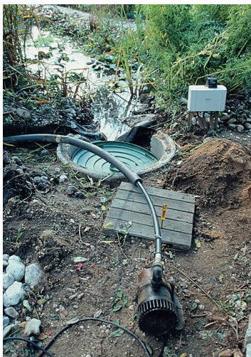
Betonová skruž jako čerpací jáma
