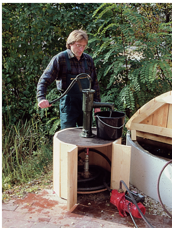
Sokl na jet-čerpadlo
