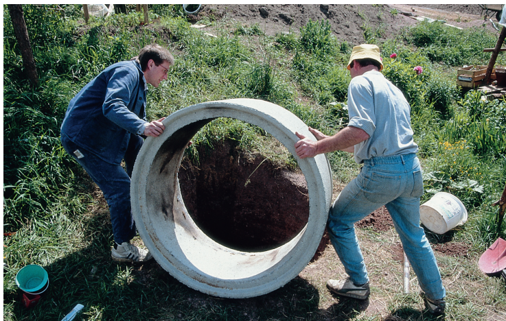
Betonová skruž se používá ke stavbě studní.
