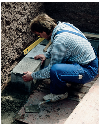
První cihly na základě
