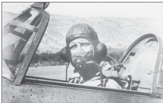
Fotografie pilota letounu Hurricane působícího na Středním východě jasně demonstruje, že u kyslíkové masky typu D nebylo dokonalé utěsnění. Typ uvedený na obrázku je varianta 3 s elektromagnetickým mikrofonom typ 21. (foto ze sbírky A. S. Batese)
