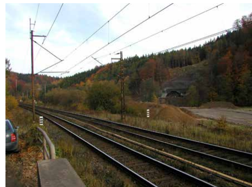
Výstavba tunelu Malá huba 22.10.2004, archiv SUDOP PRAHA a.s.
