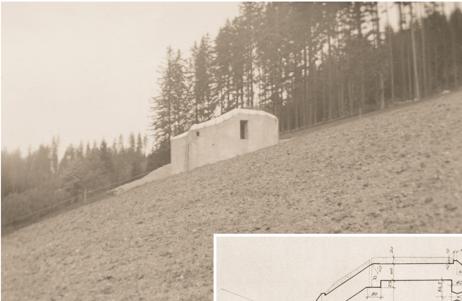
Pro umístění dvoustřílnových objektů LO v prudkých svazích ve sklonu přes 20 % byly vyprojektovány tzv. lomené objekty . Na rozdíl od šikmých objektů měly v obou střeleckých místnostech rovné podlahy, jejich výškový rozdíl (zpravidla 100 cm, mohl být ale i větší) byl řešen čtveřicí schodišťových stupňů výšky 25 cm. Na této fotografii je zachycen objekt CH1/106/A-140N lomený (stupňový) vlevo u Rýžoviště nedaleko Harrachova. Směr lomení se udával opět při pohledu z týlu směrem na tu stranu objektu, která byla položena níže. Jak je patrné z archivního výkresu, stavba lomených řopíků byla oproti běžným objektům nejen náročnější na tesařskou práci, ale vyžadovala také zpracování většího množství dřeva, betonu a armatury. (Výkres VÚA–VHA)
