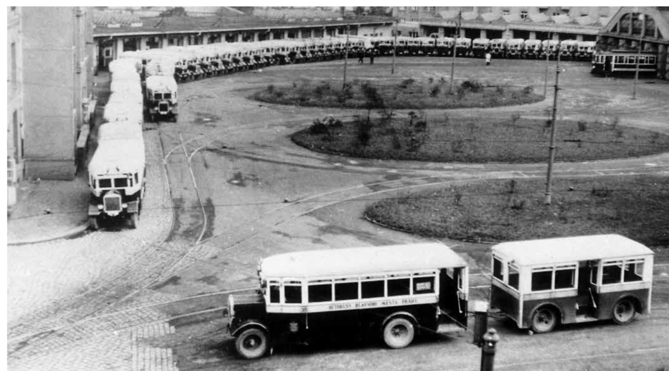
Pohled na autobusové garáže v areálu tramvajové vozovny Pankrác v roce 1932. (Zdroj: Archiv DP Praha)
