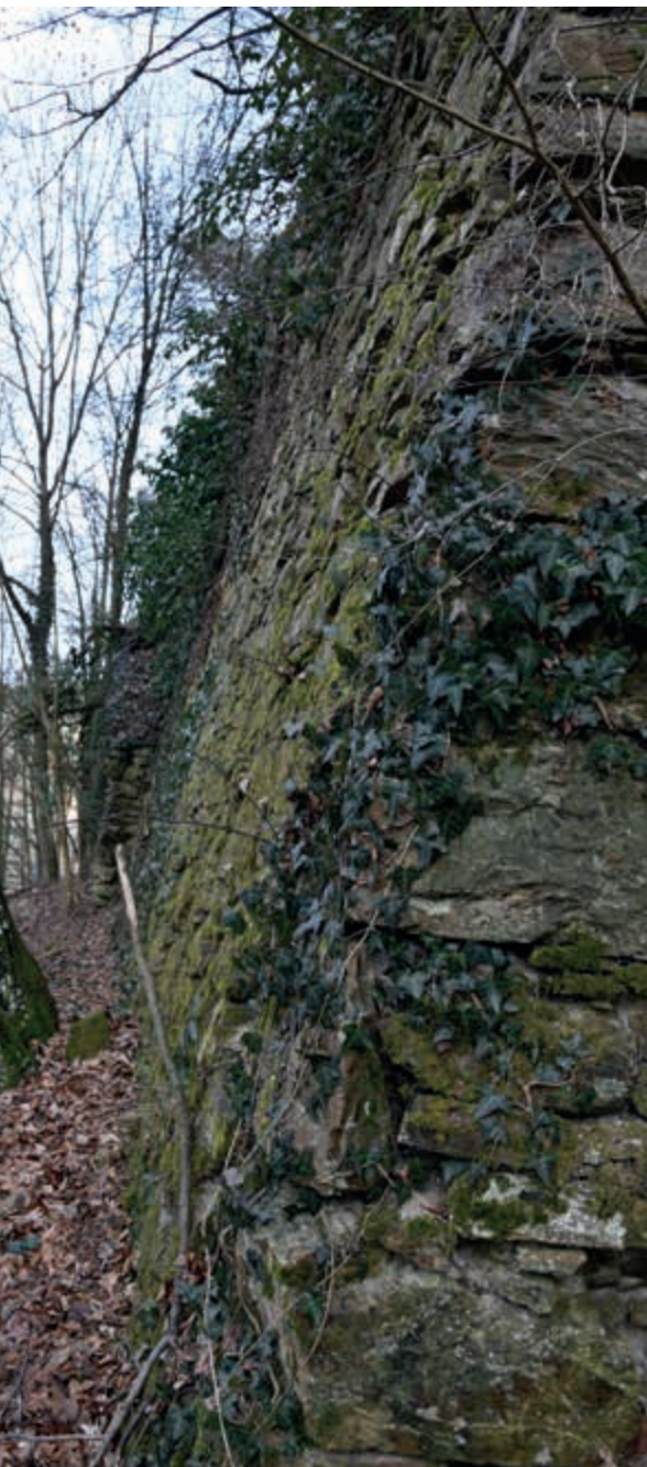
23. Mohutná tarasní zeď: Pozůstatek železářské huti Šmelcovna v údolí Bílého potoka (leden 2020)
