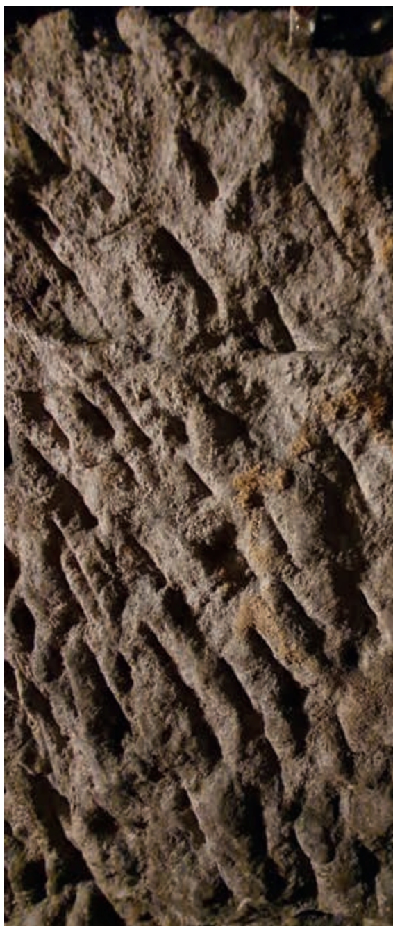
19. Detail chodby v pískovcovém podloží – tesáno ručně pomocí želízka a mlátku (červenec 2020)
