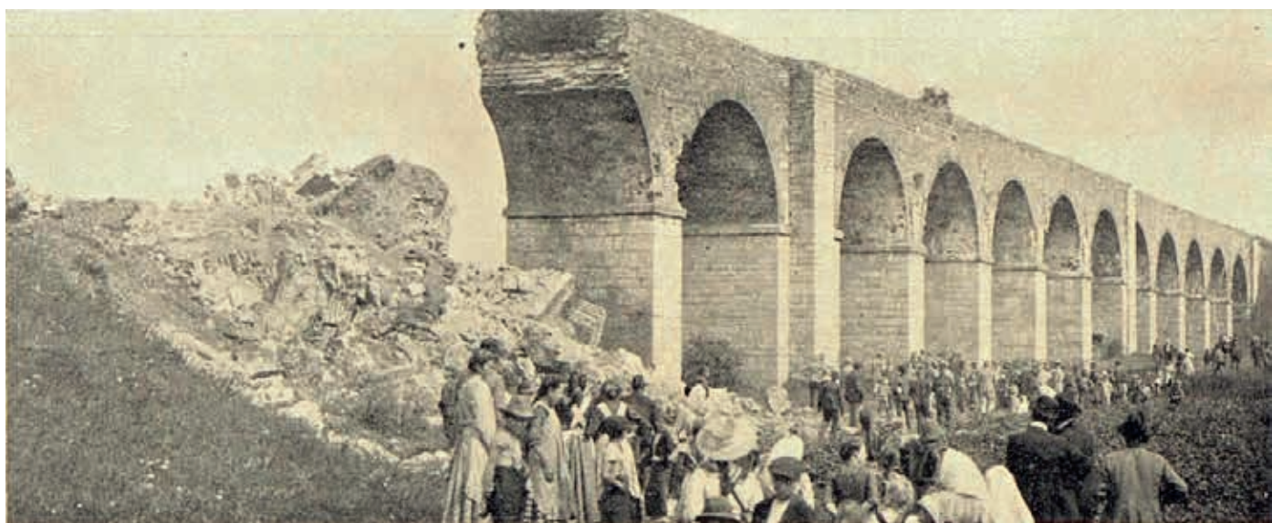
Bourání viaduktu u Drahotuší v roce 1911, sbírka Josef Bosáček
