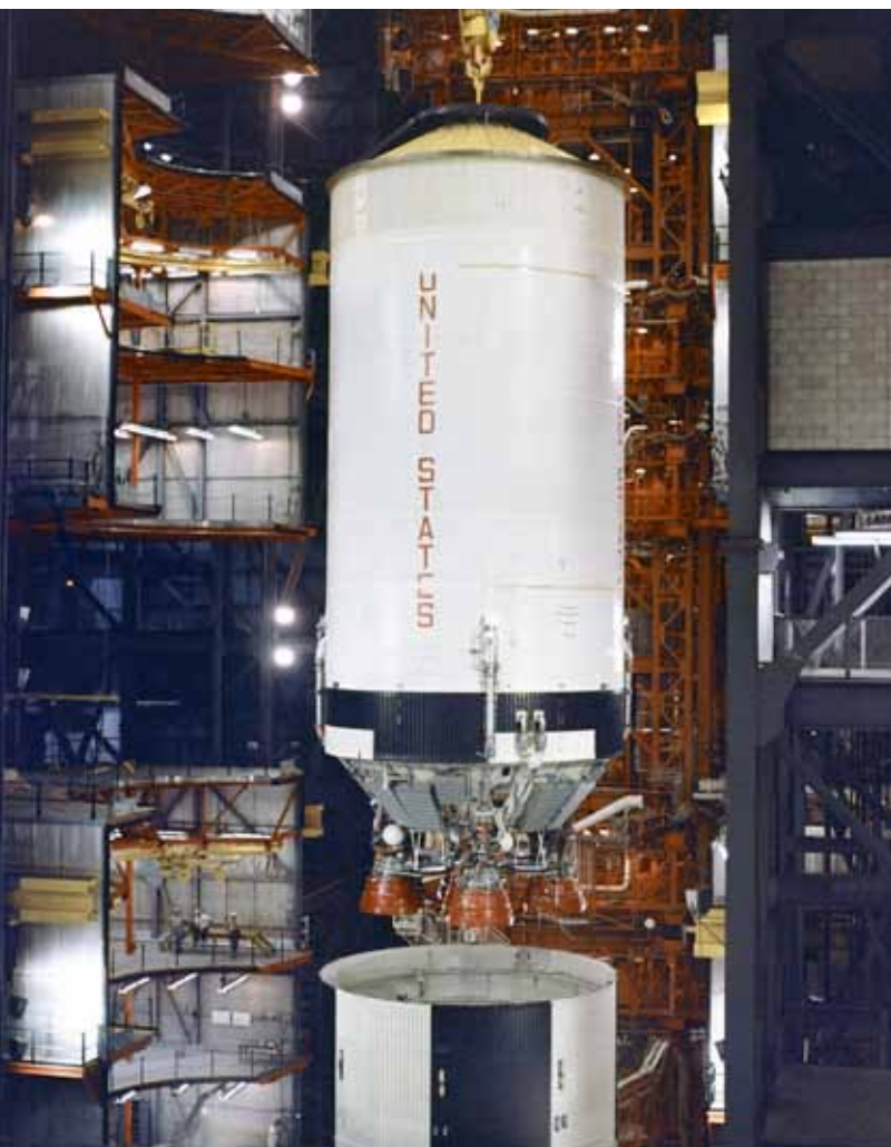
Montáž druhého stupňa S-II; nikto ešte netuší, že jeho motory sú zle prepojené
