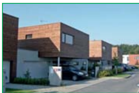
Stylově i proporčně vyvážená moderní řadová zástavba příměstského typu.
