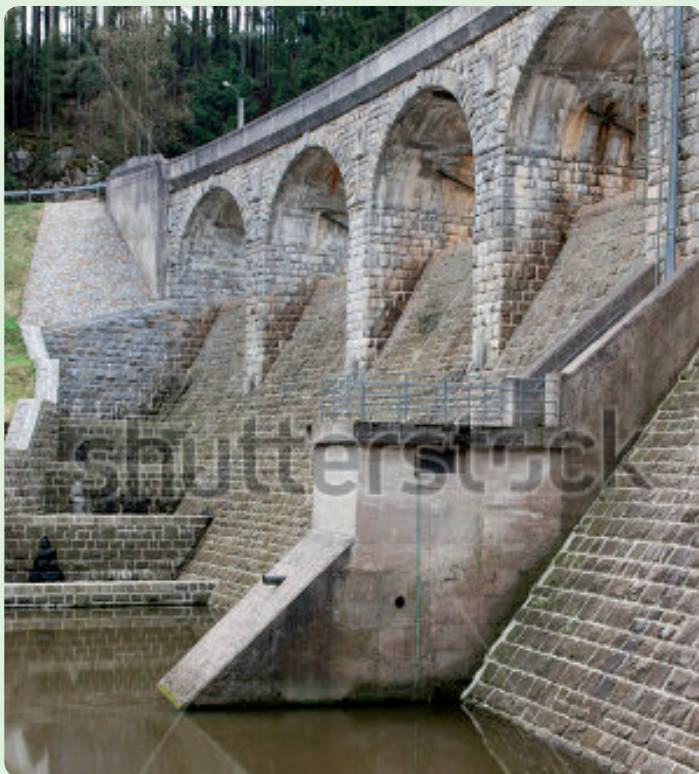
▲ Asi deset kilometrů jihovýchodně od Humpolce stojí na řece Želivce zajímavá hráz z lomového kamene vodního díla Sedlice.
