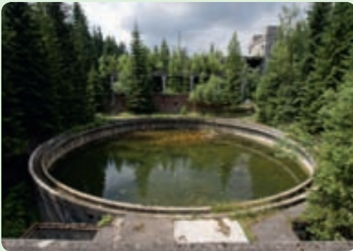
▲ Bazén zahušťovače kalů, v pozadí úprava. Celý objekt byl původně zastřešen, ale v poválečných letech byl silně poškozen a částečně vyhořel.
