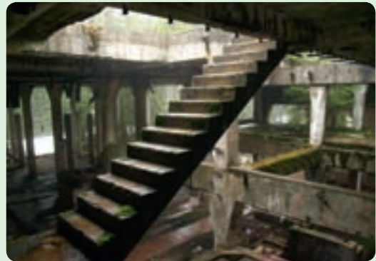
▲ Vnitřek úpravy. Její provoz byl zahájen v roce 1943, celkově vyšla výstavba celého závodu na necelých dvanáct milionů říšských marek.
