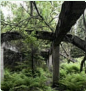
▲ Bazén zahušťovače kalů, v pozadí úprava. Celý objekt byl původně zastřešen, ale v poválečných letech byl silně poškozen a částečně vyhořel.
